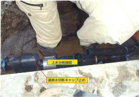
配管接続は正状況
